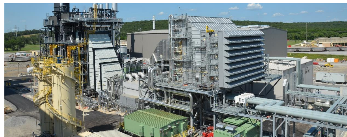
納入先 プラント名(国名) 出力 運転開始年 Grand River Dam Authority社 グランドリバーエネルギーセンター(アメリカ) 50.5万kW 2017年
